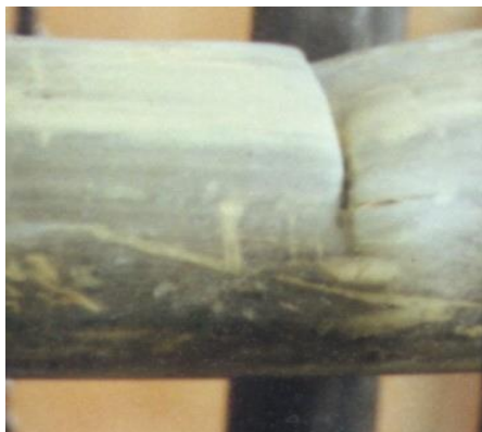
Figura 1: Falla a compresión
