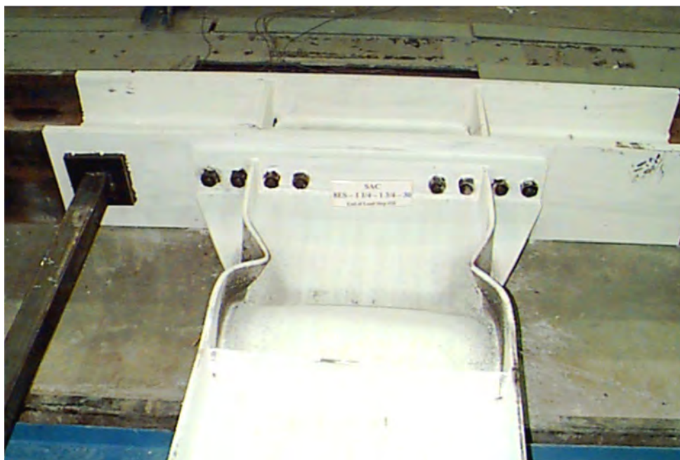
Figura 7. Ductilidad de una conexión viga-columna en acero estructural (foto cortesía del Prof. Thomas Murray)
