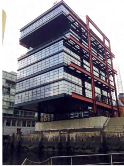
Figura 14. Edificio con pórticos de momento exteriores
