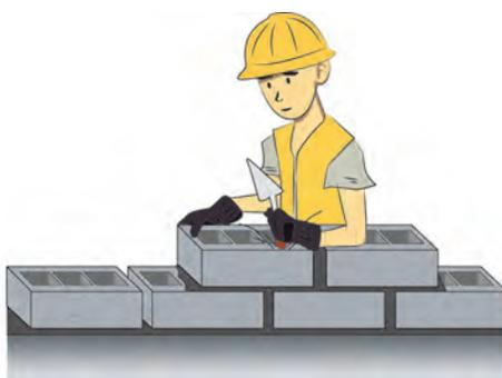
Figura 65: **Colocación de bloques trabados**
