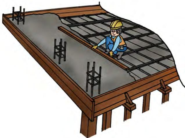
Figura 96: **Nivelación de la losa con codal**
