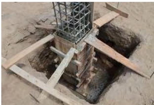
Figura 43: **Encofrado y fundido de pie de columna.**
