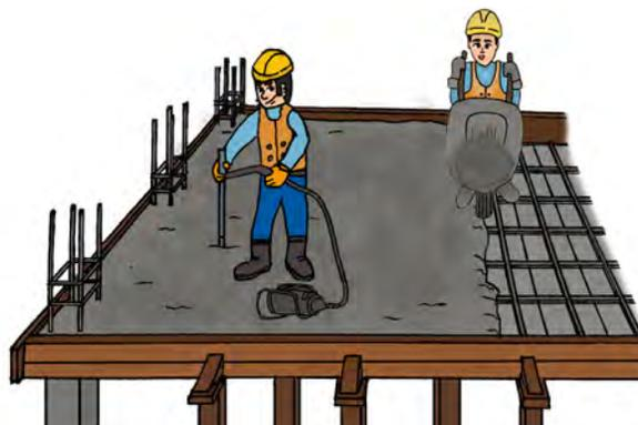
Figura 95: **Fundición y vibración de losa alivianada**
