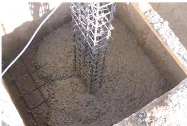
Figura 42: **Fundición de plintos.**
