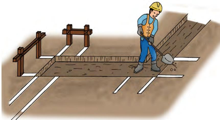
Figura 37: **Excavación a mano de plintos y cadenas**
