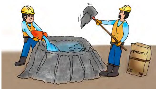
Figura 60: **Preparación del mortero**
