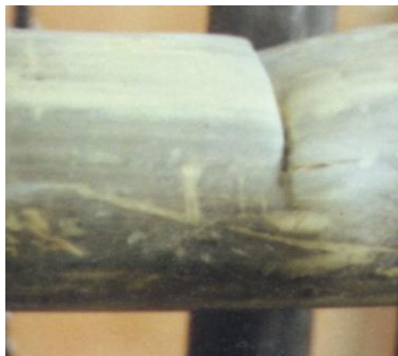
Figura 1: Falla a compresión
