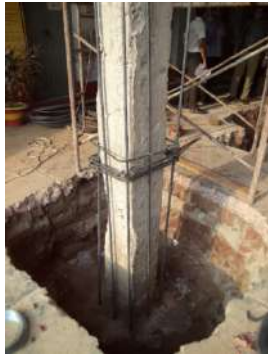
(i) Trabajo de anclaje químico y barra de refuerzo
