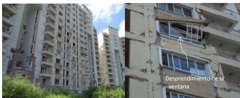
Figura E-2.23 Daños en el edificio (1) debidos al terremoto de 2015 en Gorkha, Nepal (Fuente: Proyecto JICA)
