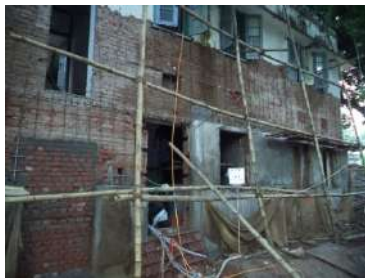
(i) Obra de barras de la pared de ladrillos en perímetro
