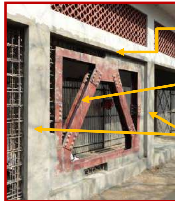
Método 4: Marco con arriostramiento metálico
