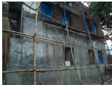
(ii) Obra de concreto de la pared de ladrillos en perímetro
