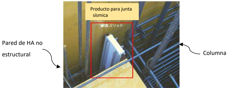
Figura E-2.30 Ejemplo de junta sísmica en un lugar de construcción (antes de la colada de hormigón)
