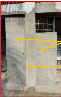
Método 3: Pared lateral de hormigón armado
