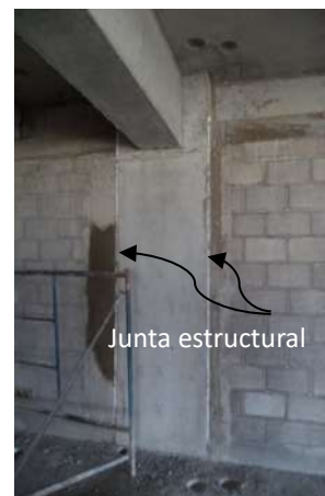
Figura E-2.28 Ejemplo de junta estructural en un lugar de construcción
