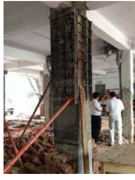
(ii) Trabajo de encofrado y hormigonado
