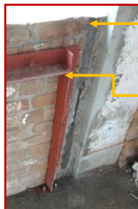
Método 6: Junta sísmica en la pared autoportante de ladrillo
