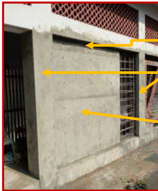
Método 2: Pared de corte de hormigón armado
