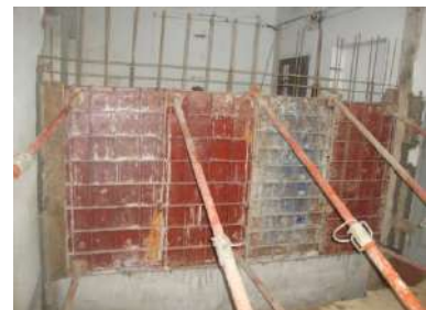
(iii) Obra de barras y concreto
