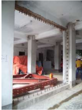
(i) Anclaje químico en la viga y la columna
