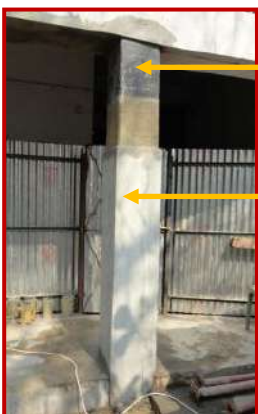
Método 5: Envoltura de fibra de carbono
